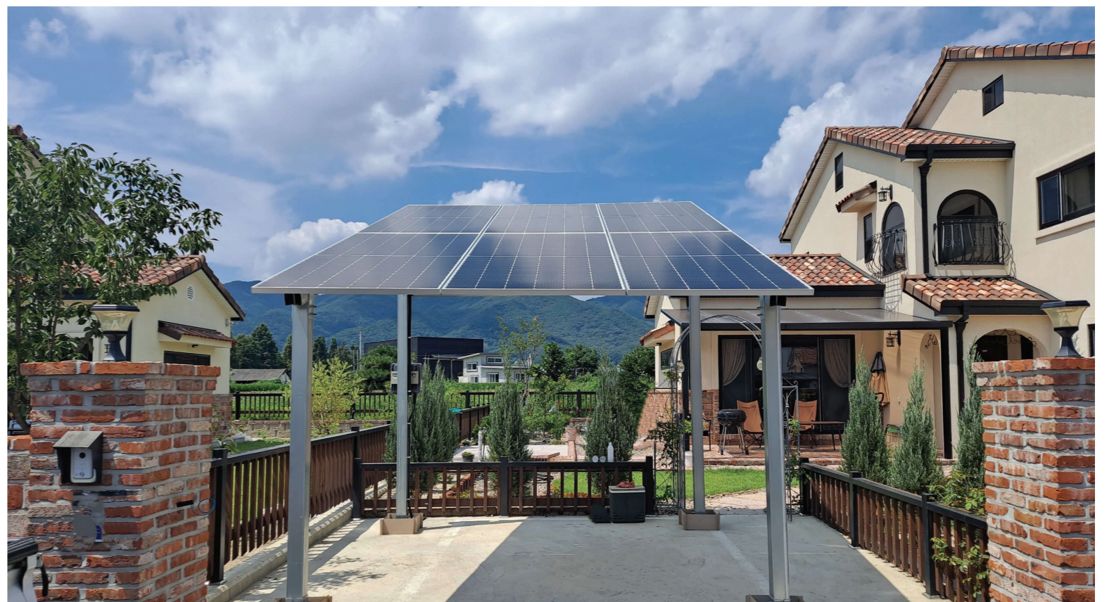
사례 1 - 방수력을 잃은 전원주택 옥상 돔 구조물에서 누수가 발생하자, 돔 위에 비가림시설 역할 태양광 발전기 시공 후 누수를 막음
